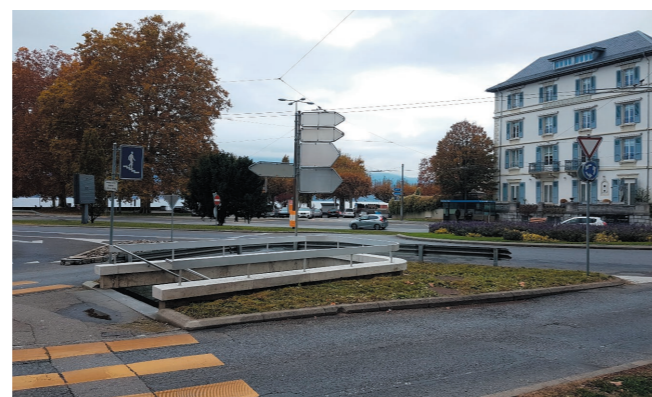
Le giratoire d'Entre-deux-Villes, en entrée de ville Est, est un espace public d'articulation majeur à valoriser pour améliorer les conditions de confort et de sécurité des modes doux et lier les différents projets alentour.
