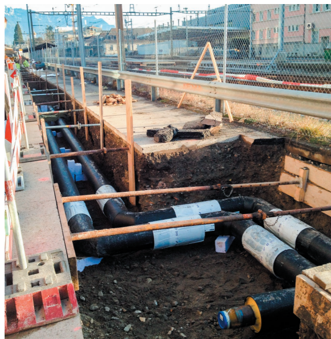
Mise en place de conduite de chauffage à distance
